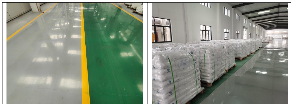
车间地面防渗措施
